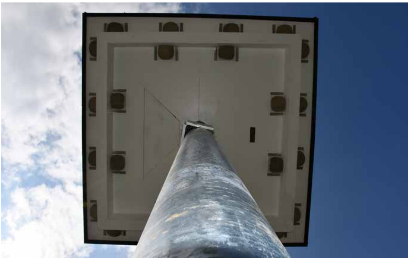
Schwalbenturm fertig aufgebaut
