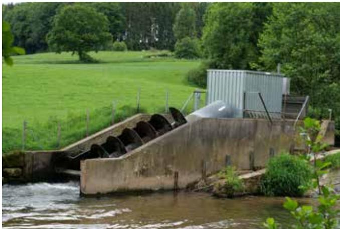
Tëscht Béiwen an Useldeng steet eng Waasserkraaftschneck. Si produzéiert Strom fir ongeféier 20 Haushalter.
